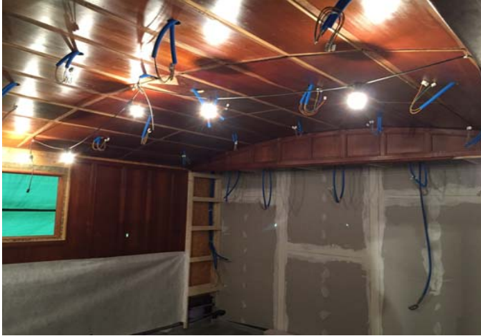
Montage der bestehenden Deckenpaneele
