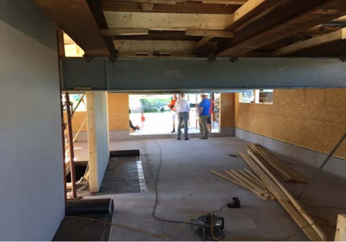
Stahlträger für Hebevorgang
