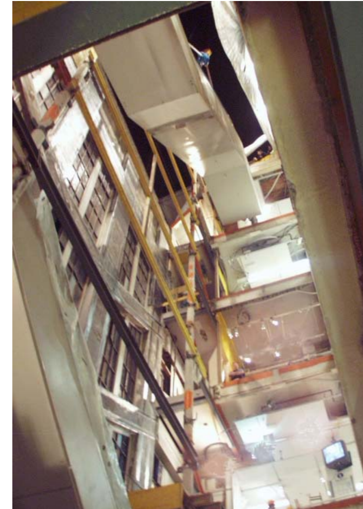
Um-, Aus- und Einbau der neuen Rolltreppen über ein Wochenende ohne Betriebsunterbruch
